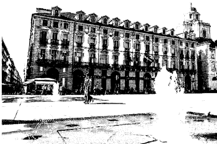
La sede della giunta regionale del Piemonte in piazza Castello 165 a Torino
